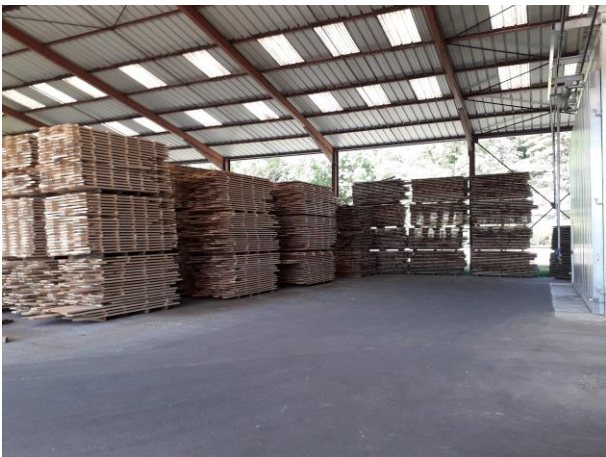
Figure 12 : Stockage bois sous auvent
